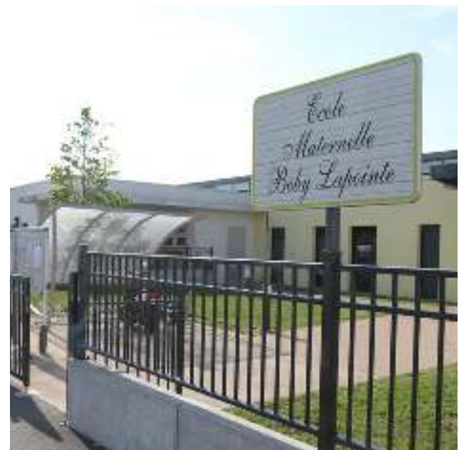
Après neuf mois de travaux, le groupe scolaire Boby Lapointe de Saint-Genis-Pouilly offre désormais de nouvelles salles de classe d'une dimension de 100 m 2 pour la partie maternelle et de 70 m 2 pour l'élémentaire.
